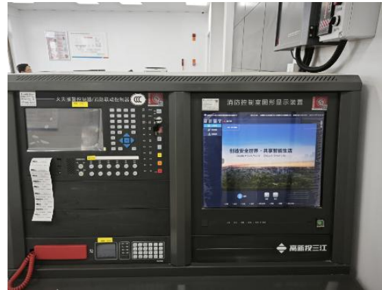
火灾报警控制器/消防联动控制器
