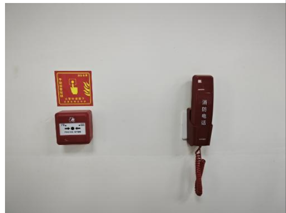
手动报警装置及报警电话
